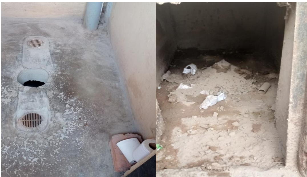
Imágenes 4 y 5. Habitación superior e inferior de las letrinas, mostrando la rejilla urinaria y el orificio destinado a las heces que se compostarán en la cámara inferior.
