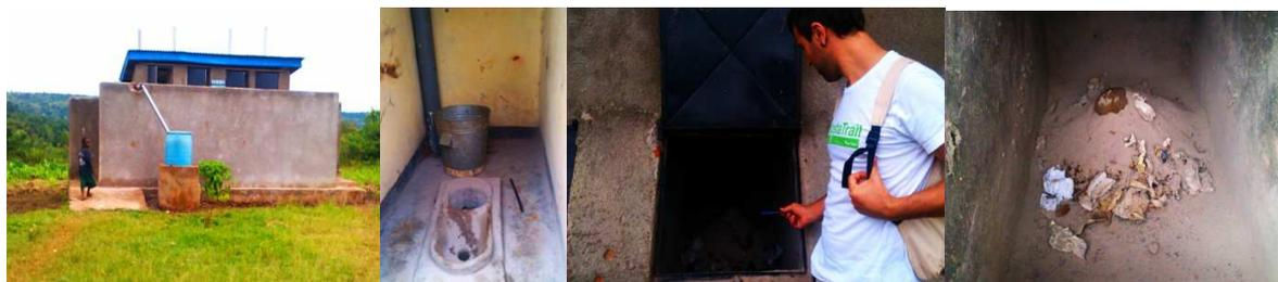
Detectamos una rotura en el desagüe del urinario y tapa del depósito, así como desgaste en la llave de paso del sistema del lavado de manos. Aunque su reparación con estaba prevista dentro de las actividades presupuestadas para la Fase 2 (2013), lo exigimos de acuerdo al objetivo final de autosuficiencia. A fin de 2013, NO se ha cumplido con esta exigencia.
